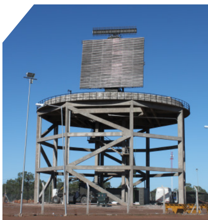
RPA-250F sobre torre.
